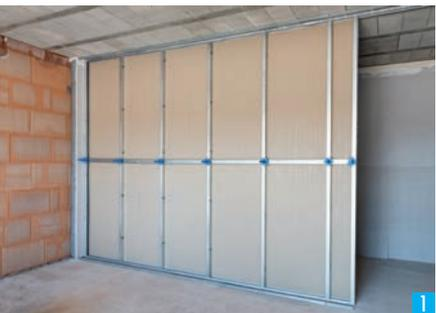
La nouvelle cloison garage isolante de Knauf est une solution à **hautes performances thermiques et acoustiques**, dédiée à la séparation en maison individuelle entre une pièce chauffée et un local non chauffé (garage, cellier, atelier...).
