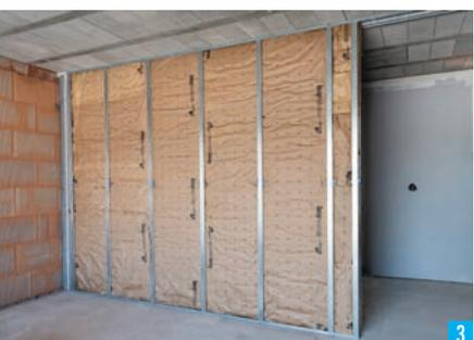
Garantie d'un ouvrage posé sans collage pour une construction sèche 100 %, la cloison isolante garage Knauf facilite également l'intégration de porte isolante sans renforts, grâce à la constitution d'un chevêtre classique selon les dispositions du DTU 25.41.
